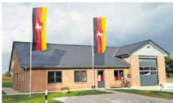
Das neue Feuerwehrhaus in Abbenseth ist der ganze Stolz der Feuerwehrkameraden, das in nur zehn Monaten errichtet wurde.
